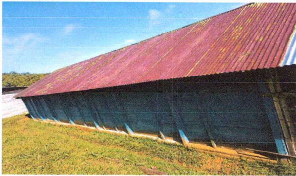
FOTO 1: Reparacion de techo
